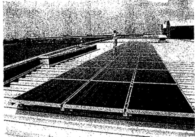
る建築物がないのが特長。このほど、240ワットのパネル42枚を設置した。年間発電量は8978キロ時で、約34万円の売電収入を見込む。
